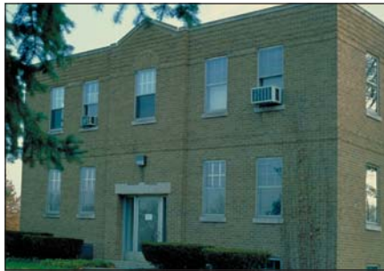
El edificio del Geoscience en Michigan. Originalmente fueron las oficinas de la Asociación Lake Union. Más recientemente, albergó al Instituto de Arqueología Siegfried Horn, y luego fue demolido en el 2003. Foto cortesía del Instituto de Arqueología, Andrews University.
